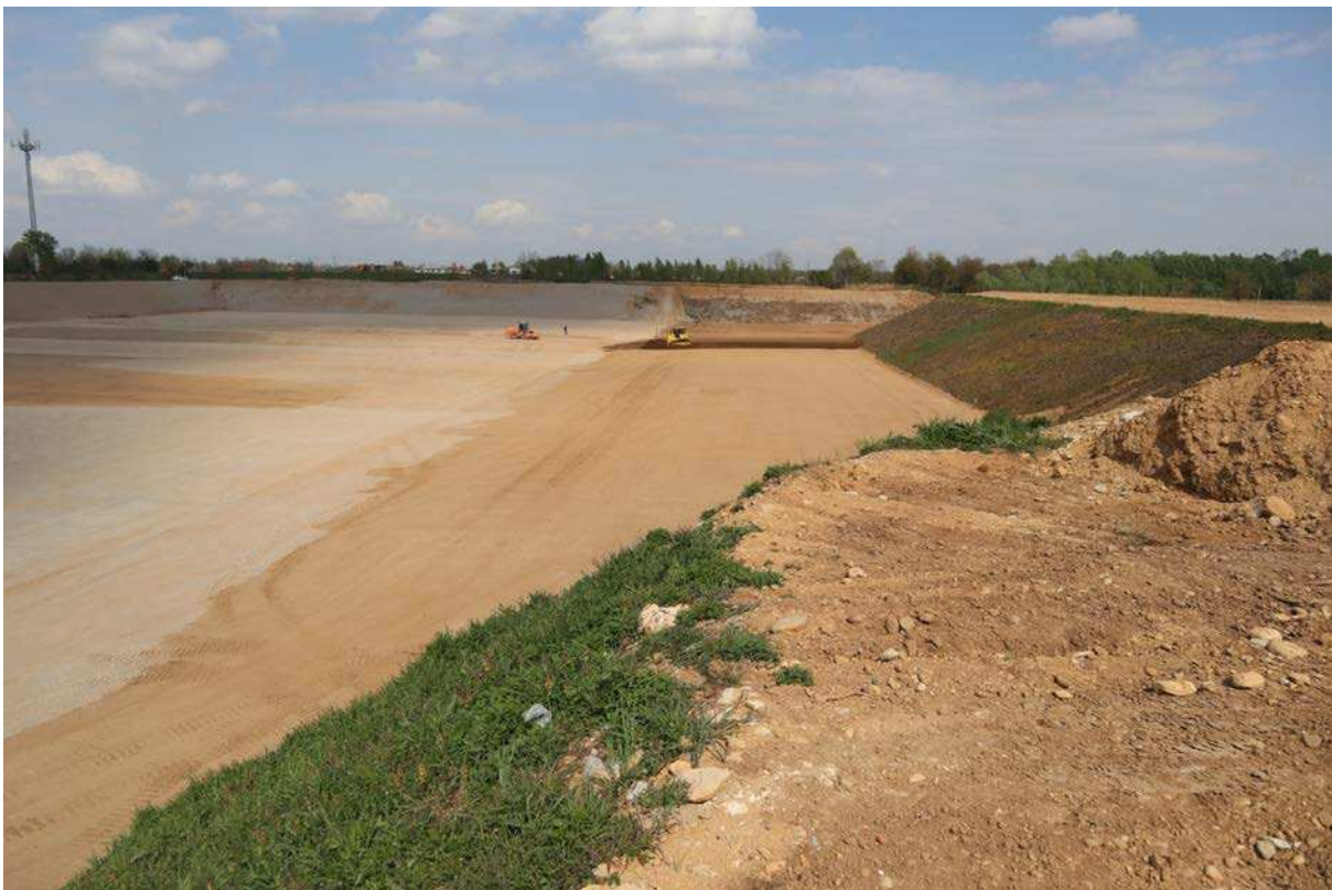
FIGURE 3_STATO DEI LAVORI AL 9 APRILE 2021
